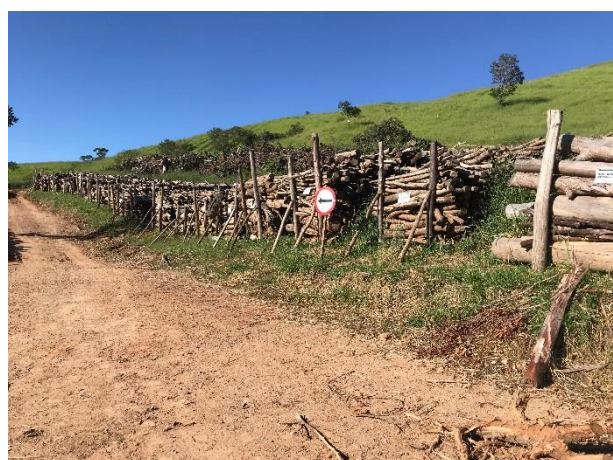
Foto 13 – Vista geral – Pátio Acesso MD 03 (Registro fotográfico 23/03/2020).
