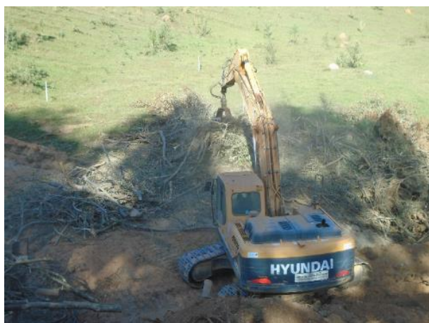
Foto 21 – Escavadeira Pinça na triagem do material florestal - (Registro fotográfico 30/04/2020).
