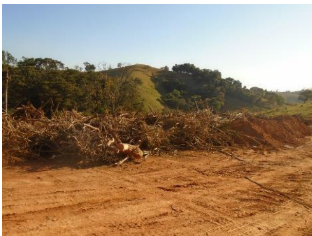
Foto 25 – Pátio de Galhadas e raízes – Acesso MD – 03 (Registro fotográfico 30/04/2020).
