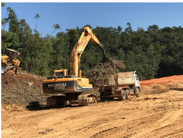
Foto 23 – Atividade de carregamento do Caminhão Basculante - (Registro fotográfico 24/03/2020).
