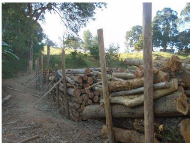
Foto 15 – Travamento de segurança – Pátio Acesso MD 03 (Registro fotográfico 30/04/2020).
