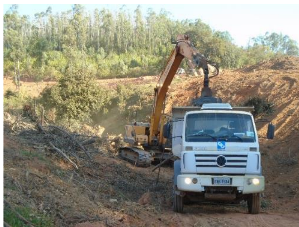
Foto 24 – Carregamento Caminhão Basculante - (Registro fotográfico 30/04/2020).
